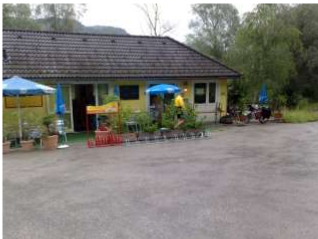
Restauranten der var ved at blive oversvømmet.
