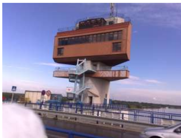
Kraftværk og slusernes styringscentral.
