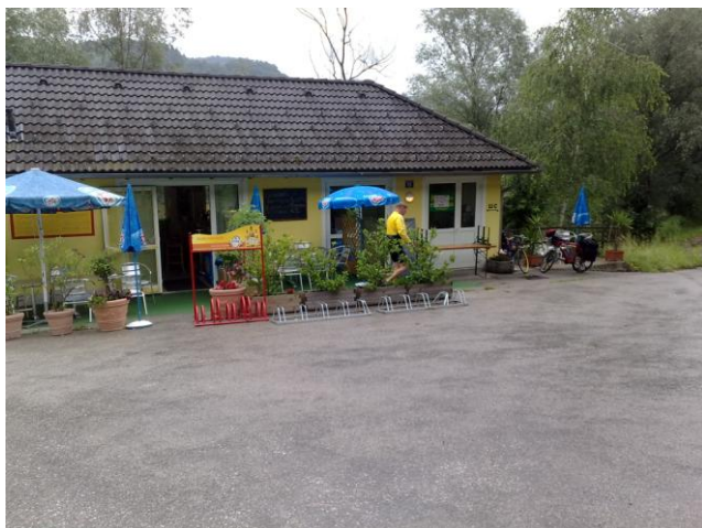
Restauranten der var ved at blive oversvømmet.
