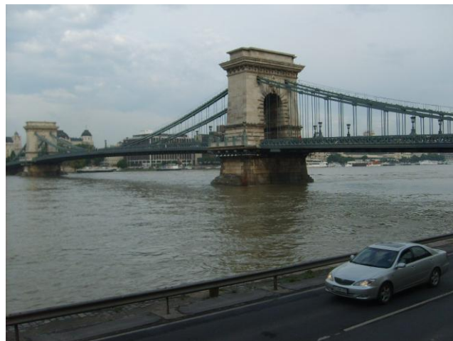
Kædebroen bygget i 1839-49, 380meter lang.
