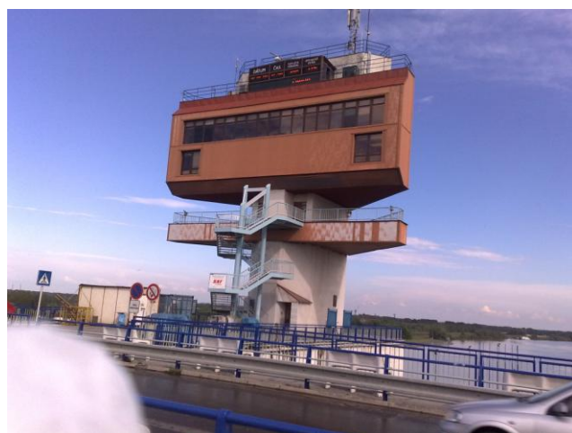
Kraftværk og slusernes styringscentral.
