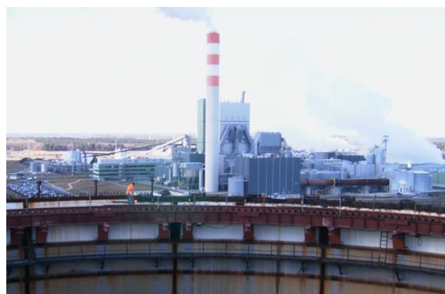
Fra den gamle reaktor med udsigt til det nye atomkraftværk.
