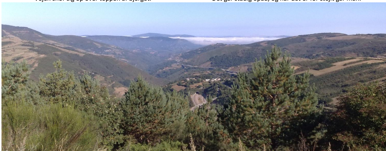
Så er vi over skyerne, hvor motorvejstunelen kigger ud midt i billedet langt under os.
