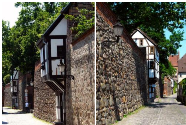
Gamle bindingsværkshuse bygget ind i bymuren.
