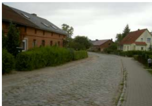
Brostensvej igennem landsbyerne.
